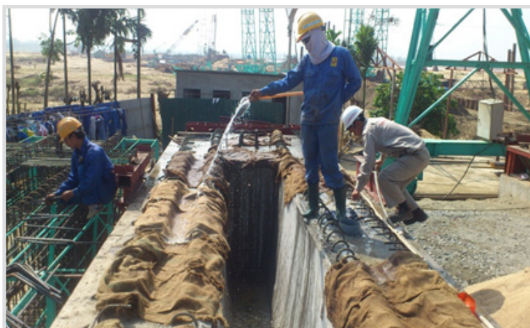
↖ Thi công bảo dưỡng bê tông dầm Super T
