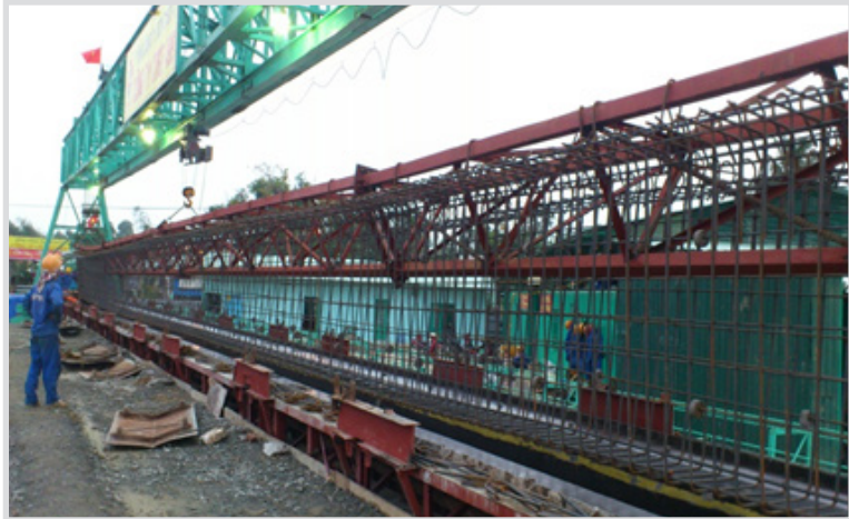
↳ Thi công lắp đặt cốt thép dầm Super T
