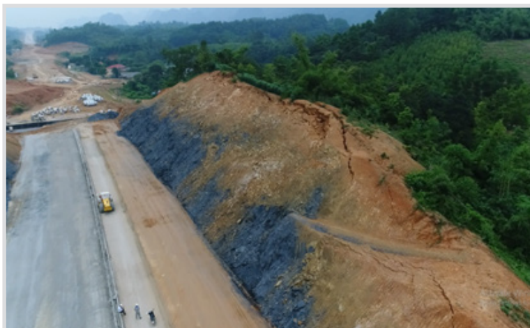
↖ Sạt lở mái taluy dương
