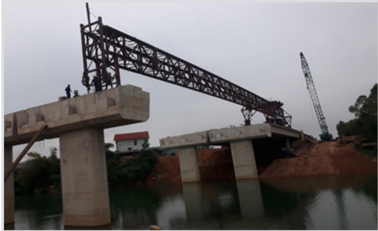
↖ Thi công lắp đặt dầm Super T bằng giá 3 chân
