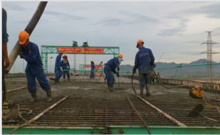
↖ Thi công đổ bê tông bản mặt cầu
