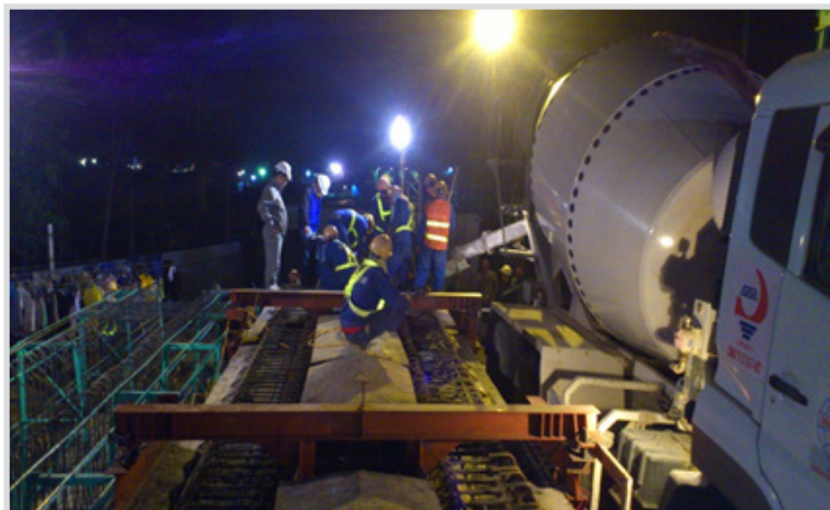
↖ Thi công đổ bê tông dầm Super T
