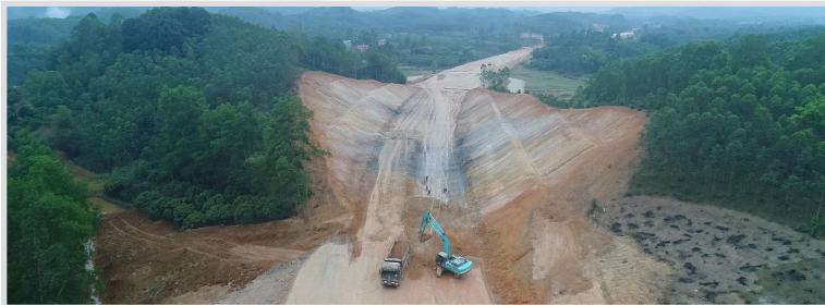
↻ Thi công đào nền đường cao tốc Bắc Giang - Lạng Sơn
