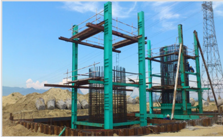
↶ Thi công lắp đặt cốt thép thân trụ
