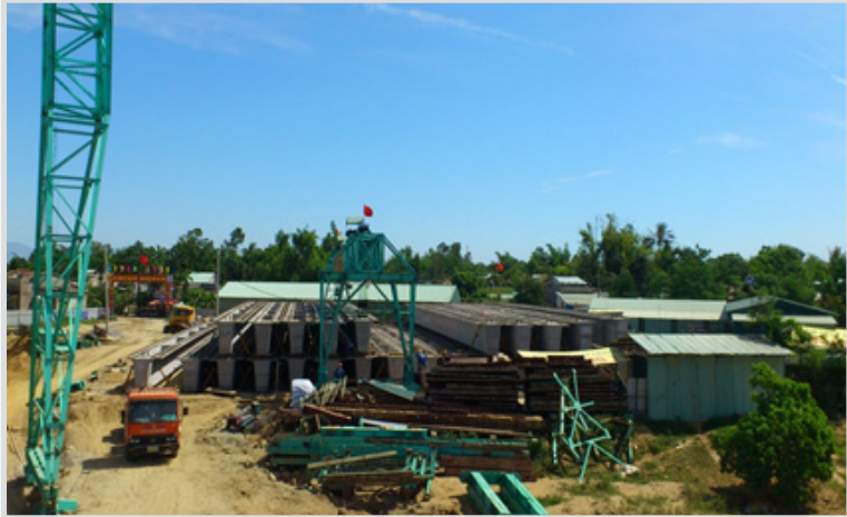
↶ Thi công bãi chứa dầm Super T
