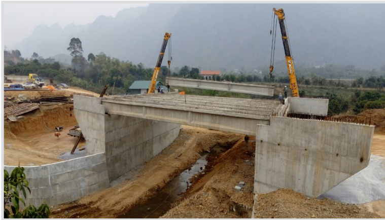
Thi công lao dầm
