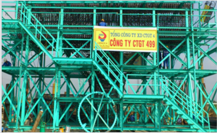
↖ Thi công lắp đặt cốt thép xà mũ trụ
