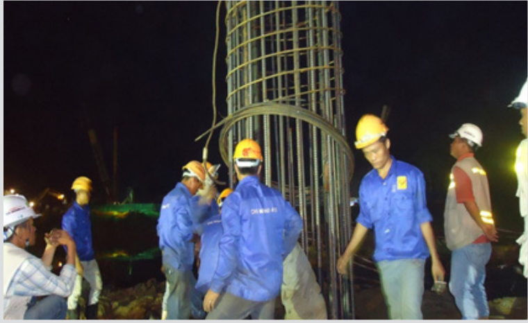
↻ Thi công hạ lồng cốt thép cọc khoan nhồi
