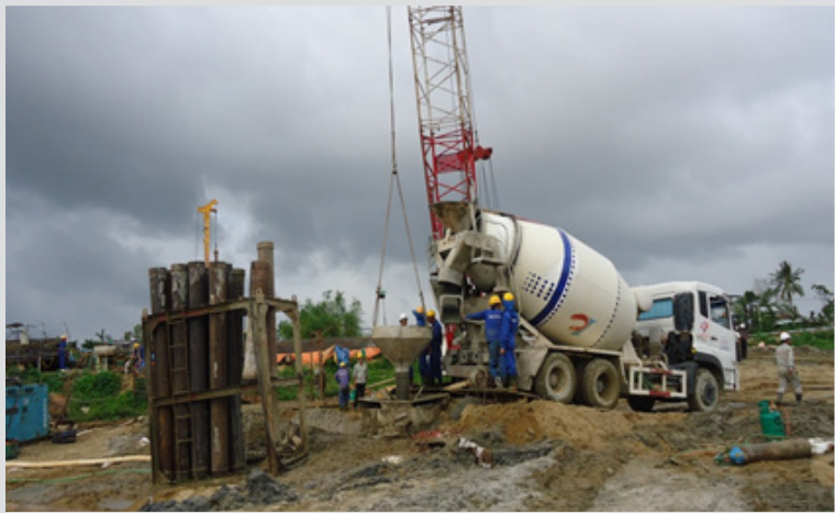
↻ Thi công đổ bê tông cọc khoan nhồi
