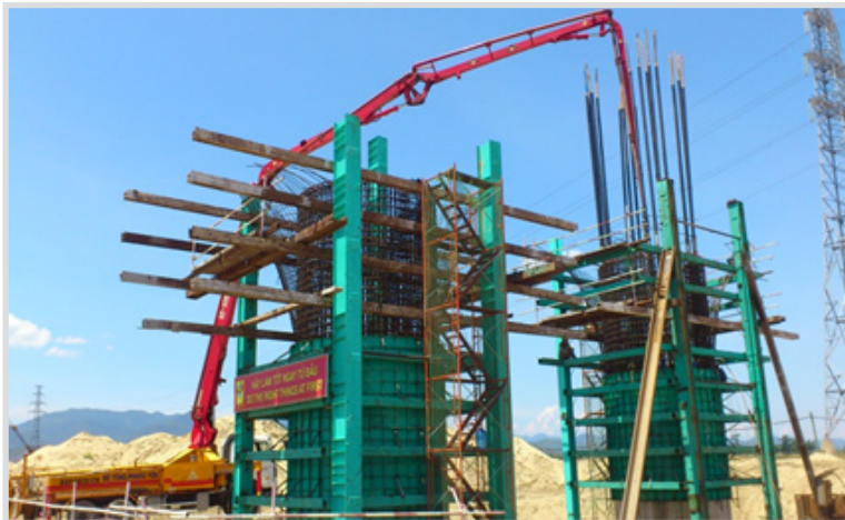
↶ Thi công đổ bê tông thân trụ
