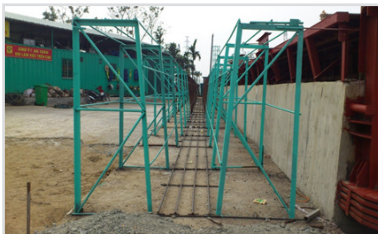
↪ Thi công khung gia công lồng cốt thép cho dầm Super T
