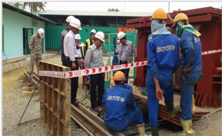
↳ Thi công căng kéo cốt thép DƯỠ dầm Super T
