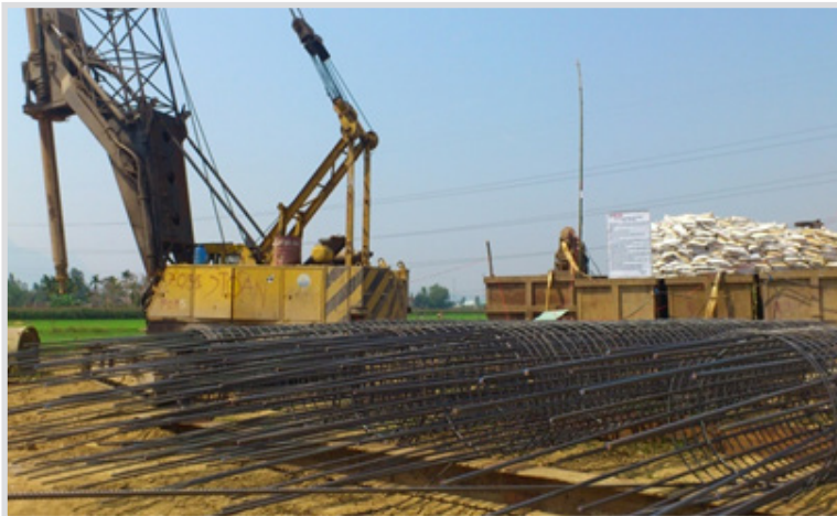
↖ Gia công lồng cốt thép thi công cọc khoan nhồi
