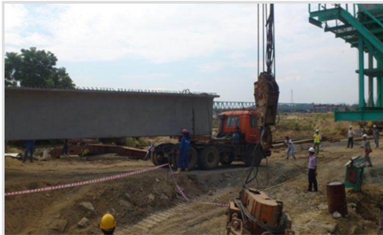
↶ Thi công vận chuyển dầm Super T
