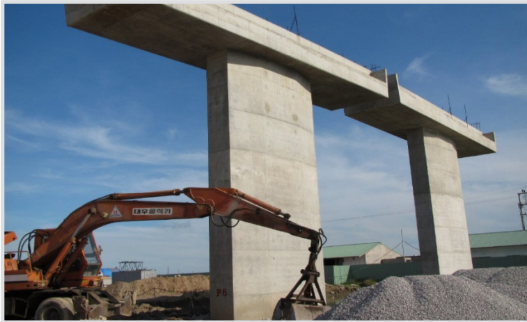
↖ Thi công trụ cầu
