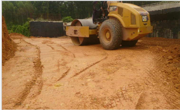
↖ Đắp vật liệu dạng hạt sau mổ không đúng quy định (đắp bằng đất)
