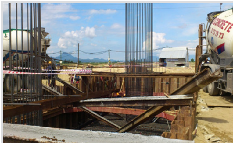
↳ Thi công đổ bê tông bộ trụ
