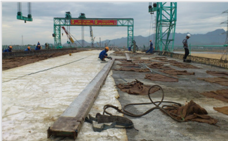
↖ Thi công bảo dưỡng bê tông bản mặt cầu
