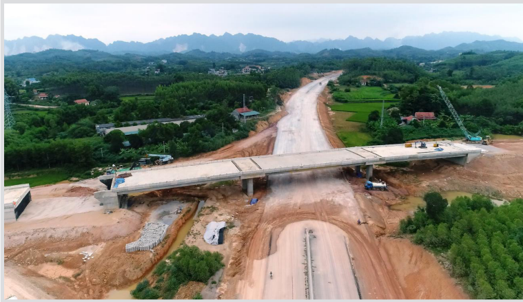
↳ Thi công cầu vượt cao tốc
