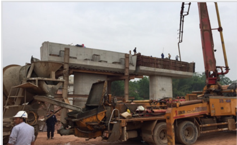
↖ Thi công đổ bê tông cho xà mũ trụ
