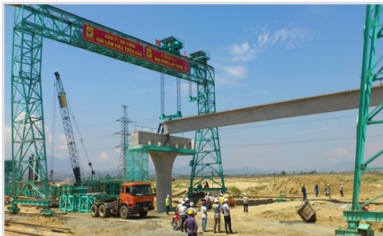
Thi công lắp đặt dầm Super T bằng giá Long Môn
