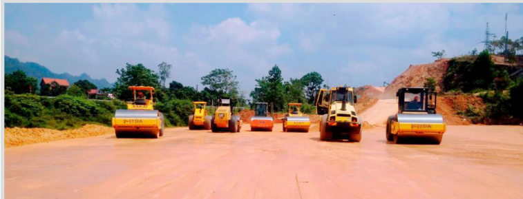
↻ Thi công đắp nền đường cao tốc Bắc Giang - Lạng Sơn
