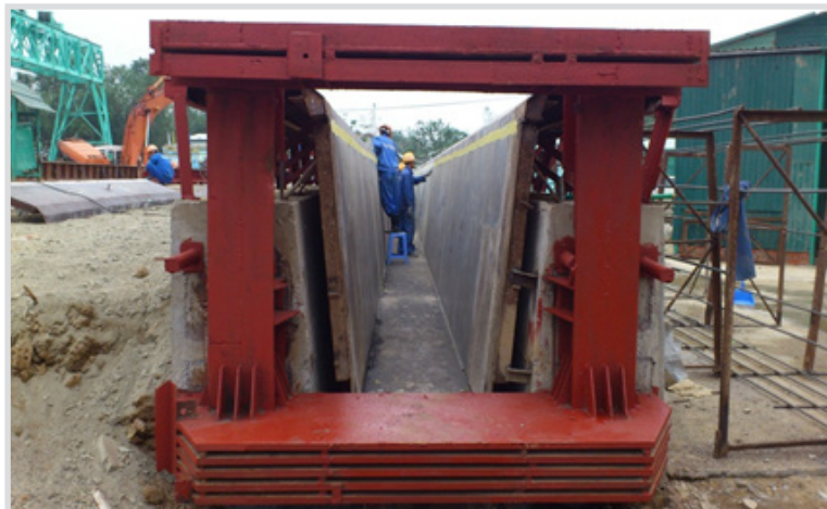
↪ Thi công lắp đặt bộ đúc dầm Super T
