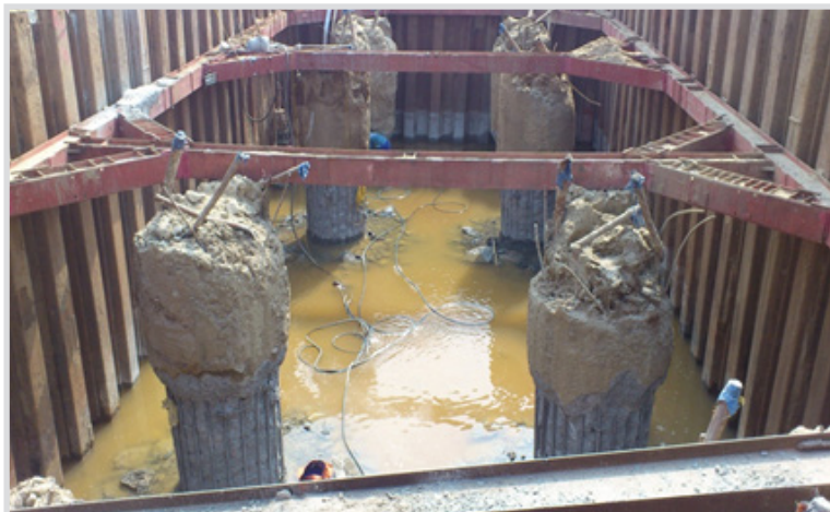
↳ Thi công vòng vây CVT và đập đầu cọc
